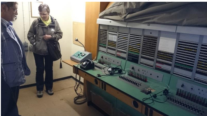
Ehemalige Telefonzentrale mit „Stöpselverbindung“
